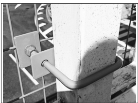
写真1 コの字ボルト用途例
