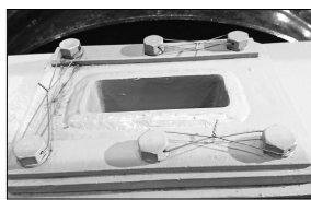
写真8 脱落防止(ワイリング)
