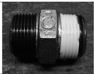
写真7 シールテープの施工方法(六角ネジの右側のおねじにシールテープを巻いた状態)
