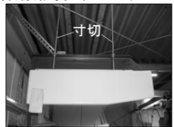
写真2 天吊りエアコンに使われている寸切ボルト
